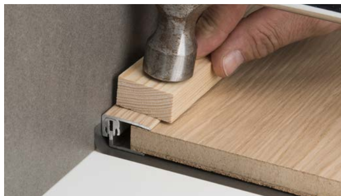
Instalace ukončovacího profilu hliníkového
