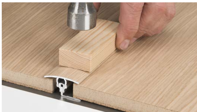
Instalace přechodového profilu hliníkového
